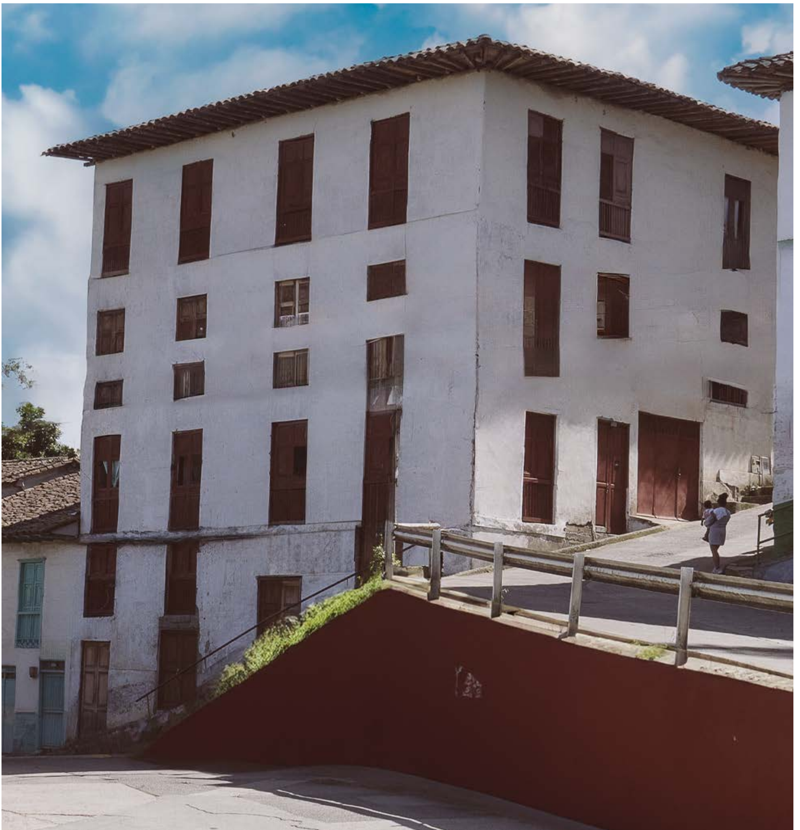
Edificación de 4 pisos totalmente construída en bahareque se encuentra en una de las entrada a la población. - Fotografía: Wilman Alberto Vásquez
