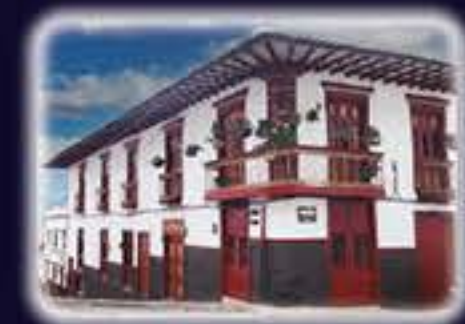
Casa construcción tradicional
