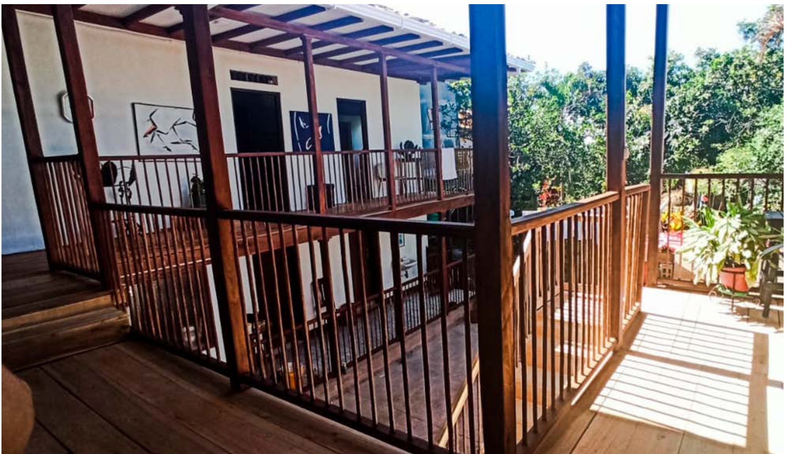
corredores interiores de construcción tradicional de la Colonización Antioqueña Fotografía Wilman Alberto Vásquez V.
